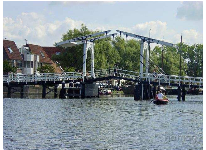
Foto:4 De "Rembrandtbrug"
